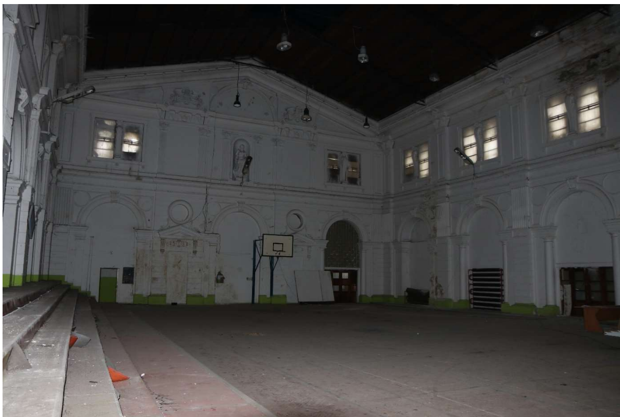
Obr. 2 – Celkový pohled do prostoru odbavovací haly od SV
