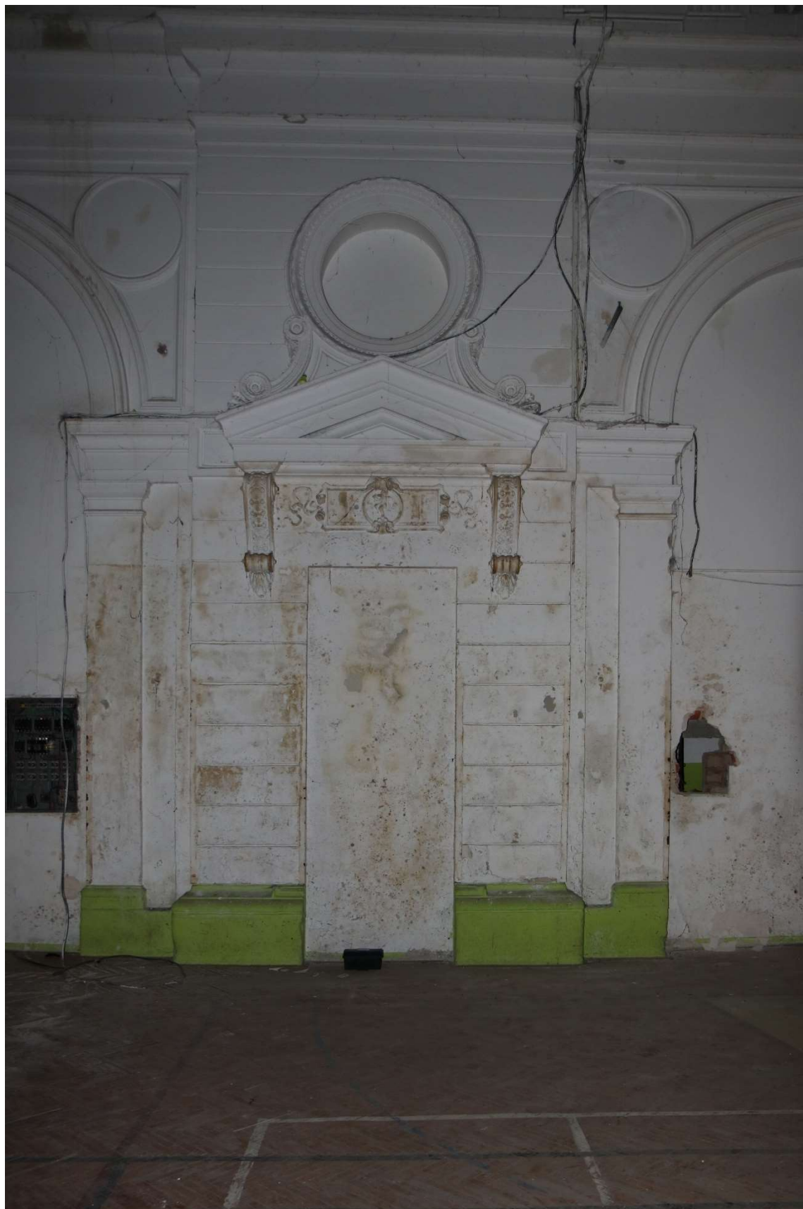
Obr. 4 – Pohled na druhotně zazděné dveřní otvory
