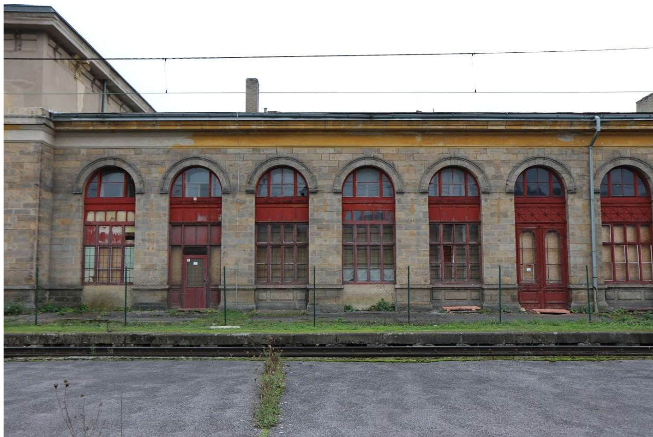
Obr. 1 – Plně valené dveřní a okenní otvory
