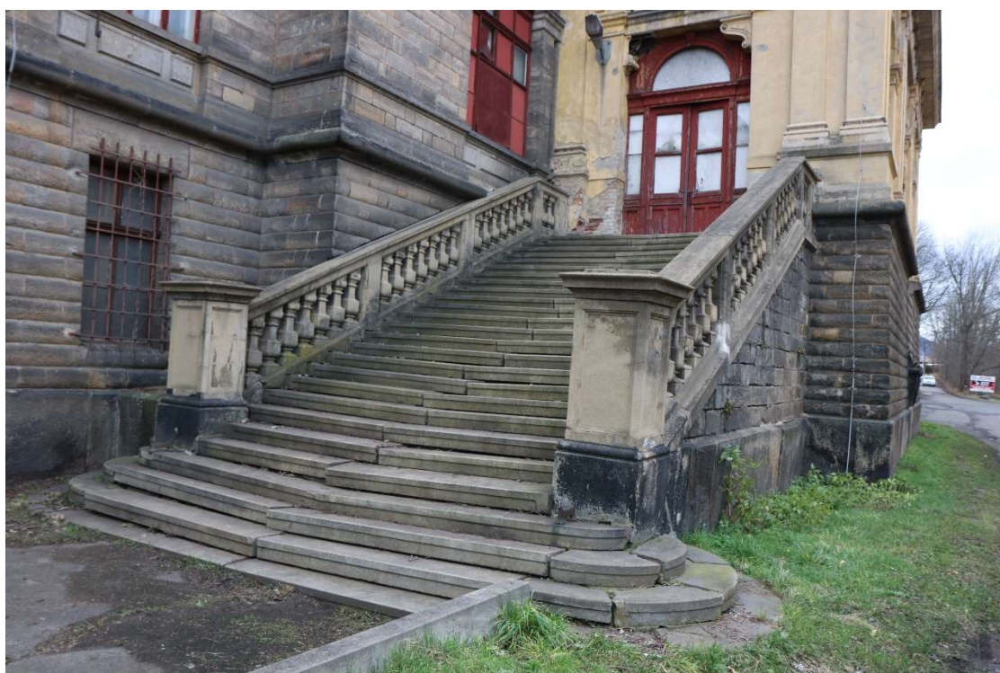
Obr. 1 – Pohled na schodiště od SZ
