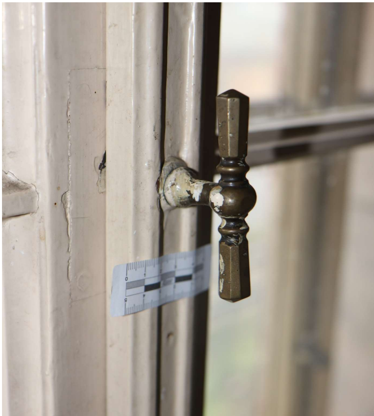
Obr. 7 - Původní dochovaný typ mosazné kliky
