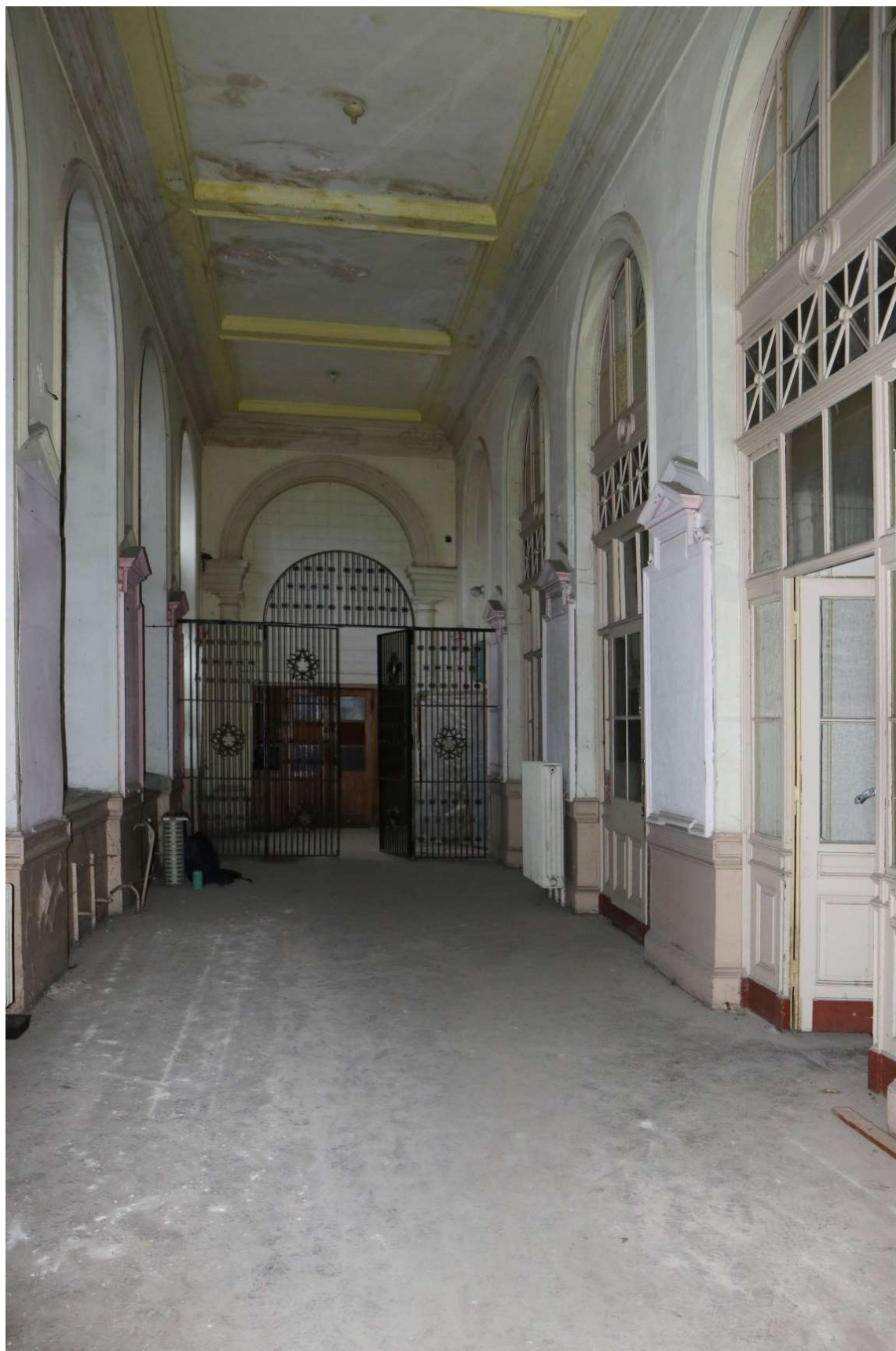
Obr. 2 – Pohled do chodby s rozmístěnými tabulemi
