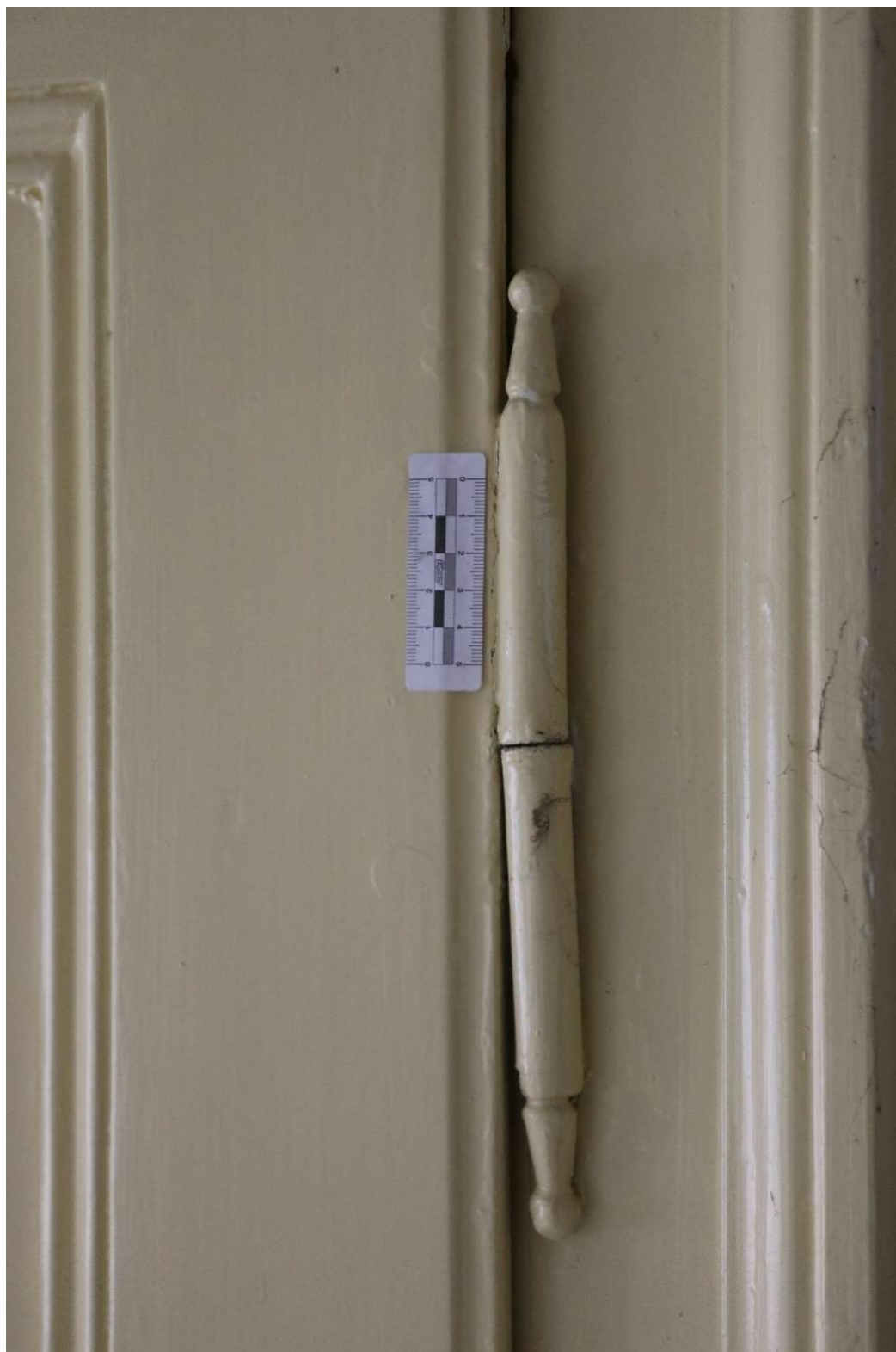
Obr. 3 – Detail kuličkového závěsu
