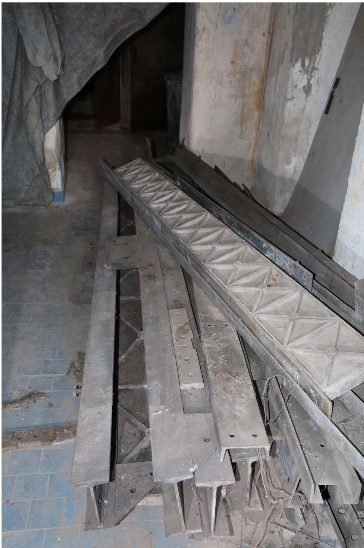
Obr. 6 – Deponovaná mostní konstrukce v kotelně budovy nádraží
