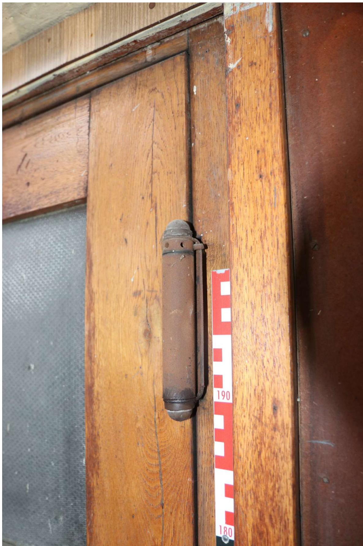
Obr. 2- Detail kyvadlových závěsů
