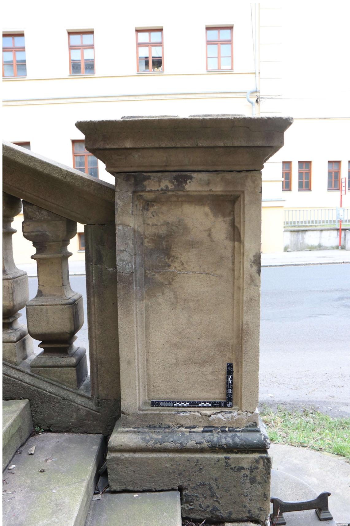
Obr. 2 – Pohled na sokl ve spodní části schodiště
