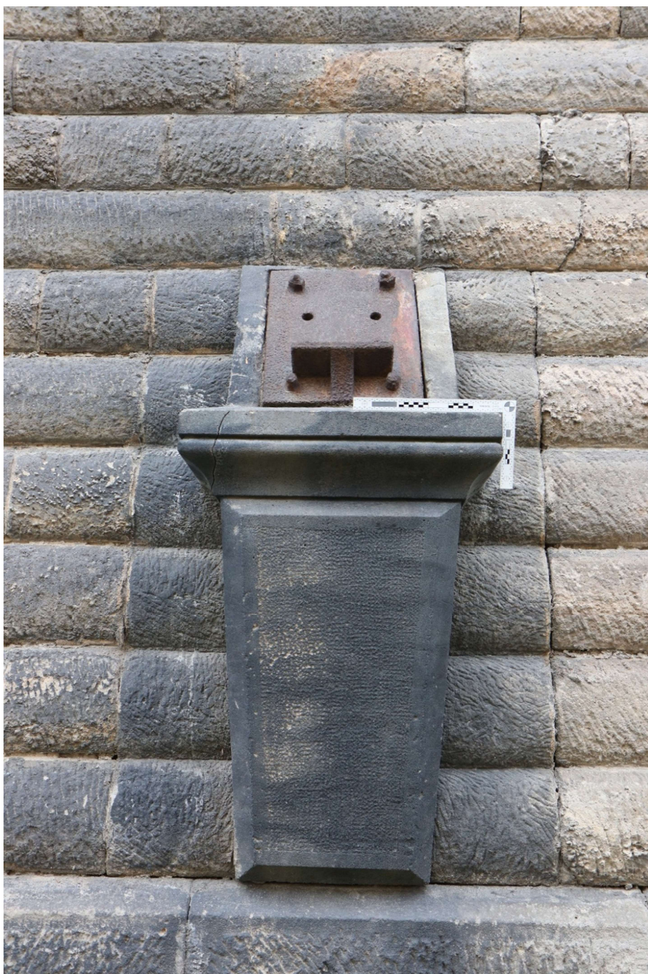
Obr. 1 – Čelní pohled na konzoly
