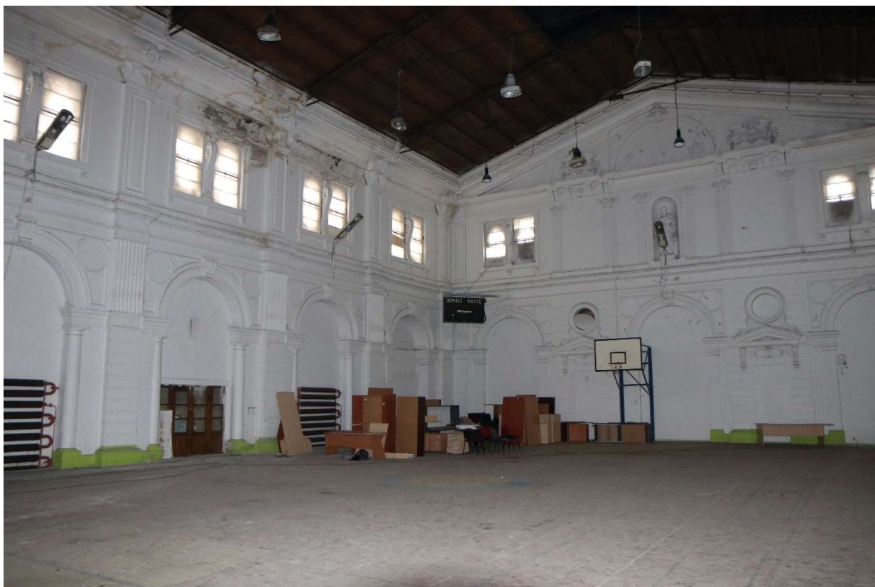
Obr. 1 – Celkový pohled do prostoru odbavovací haly od SZ
