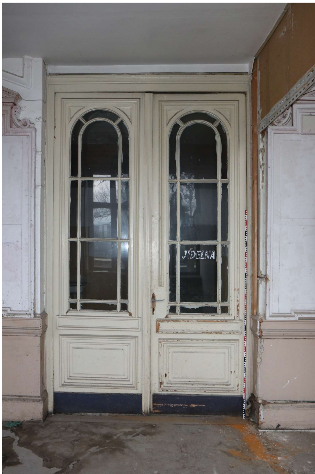
Obr. 2 – Celkový čelní pohled na dveřní výplň (typ 02)
