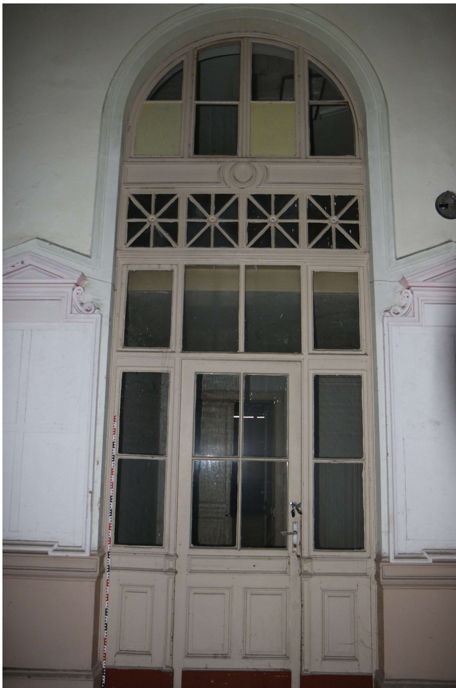
Obr. 1 – Celkový čelní pohled na dveřní výplň (typ 01)
