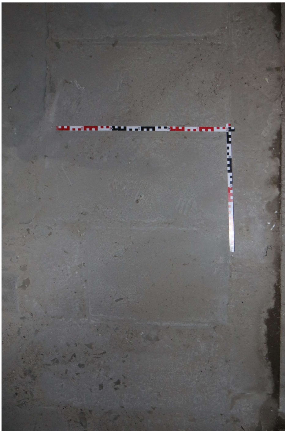
Obr. 1 – Detail deskové podlahy v části budovy F.
