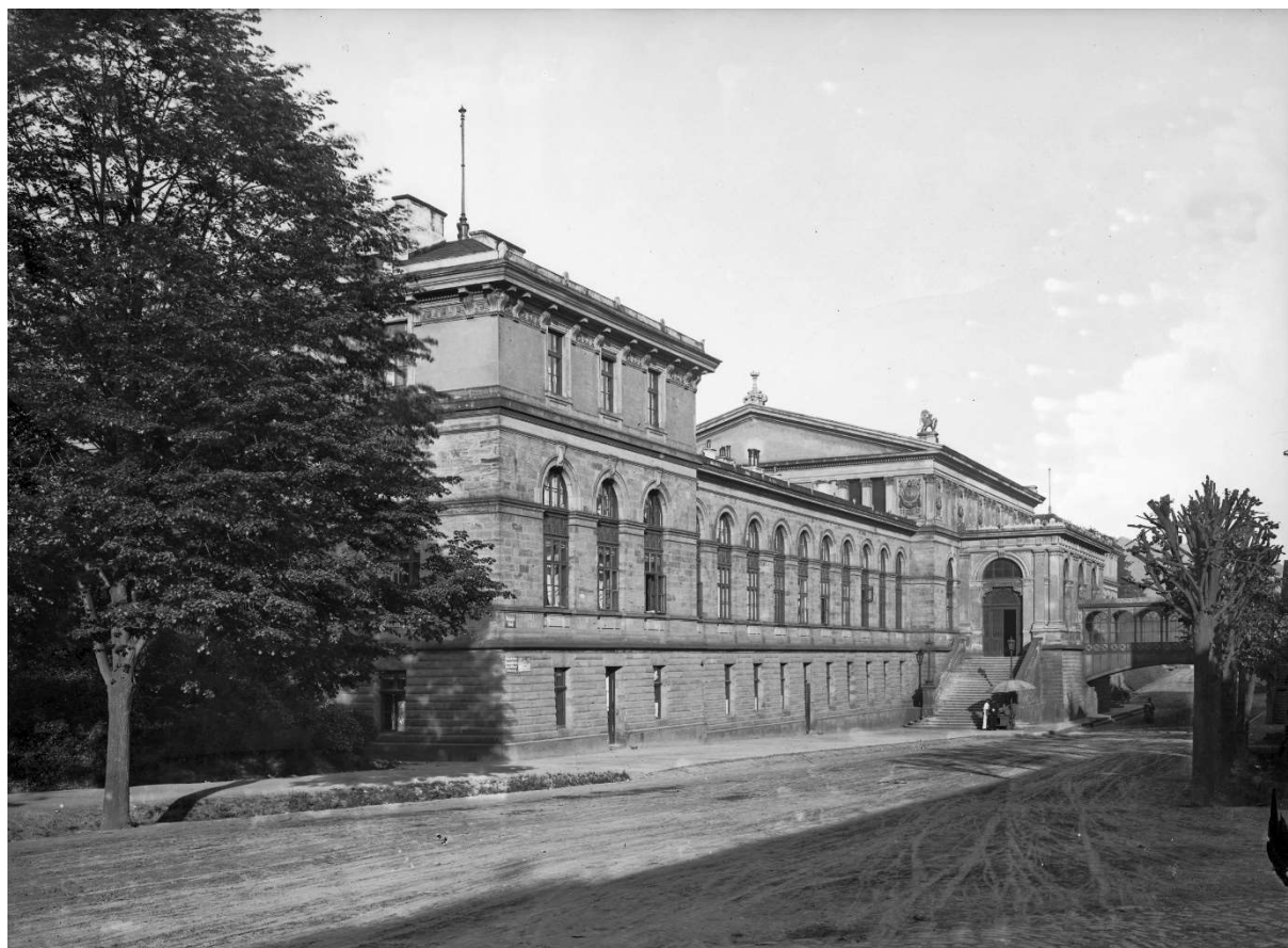
Obr. 4 – Pohled na původní stav schodiště s osvětlením
