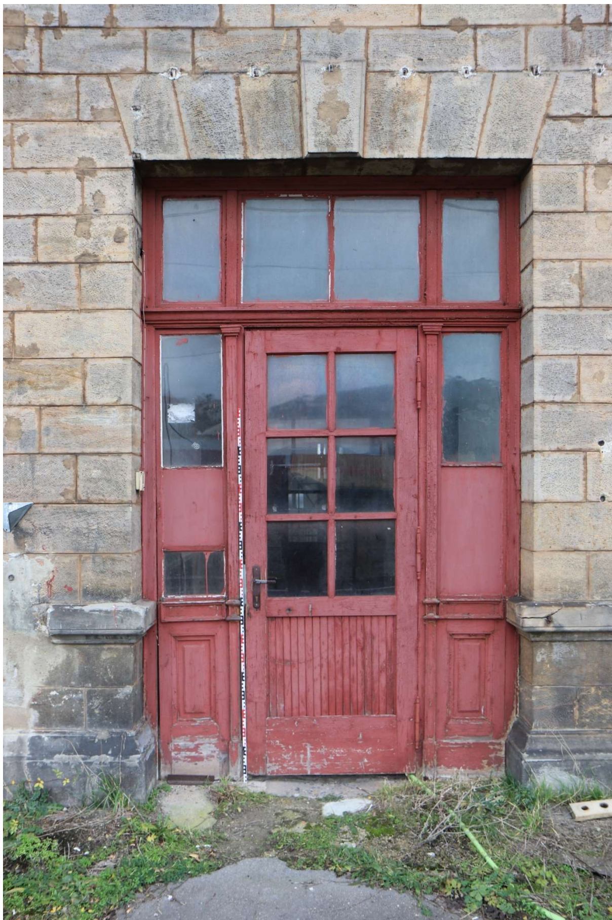
Obr. 5 – Exteriérová varianta utilitární dveřní výplně v části budovu B
